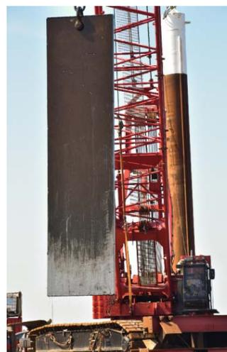
Bild 8: Das Blech dient als Schneidwerkzeug zur Zerlegung des Havaristen.
