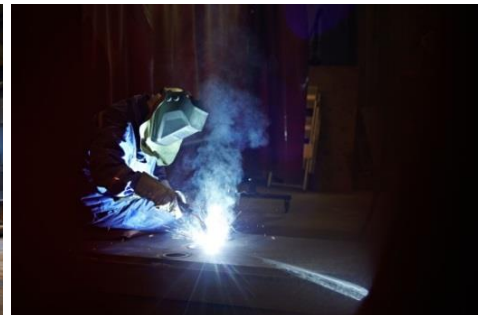
Bild 4: Die notwendige Effizienz der Fertigung bei Jebens liefert ein großer Drehtisch, auf dem der Rahmen in allen Lagen geschweißt werden kann.
