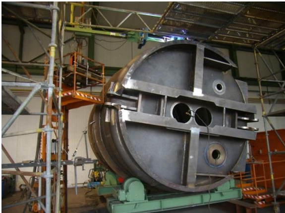
Bild 11: Die Fertigungsvorrichtung senkt die Zeiten, in denen der auf dem Gerüst liegenden Schweißer in Zwangslage schweißen muss.
