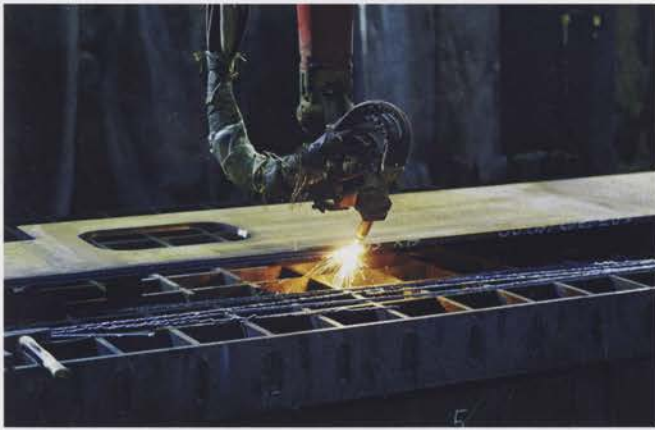
Die Brennzuschnitte inklusive Schweißnahtvorbereitungen für die Fußplatten werden direkt in die Betonsäulen mit eingeschleudert. Foto: Jebens GmbH
