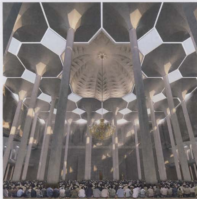
Den gesamten Moscheekomplex prägen insgesamt 618 achteckigen, langen und schlanken Säulen - auch im Gebetsaal. Grafik: Europoles GmbH & Co. KG
